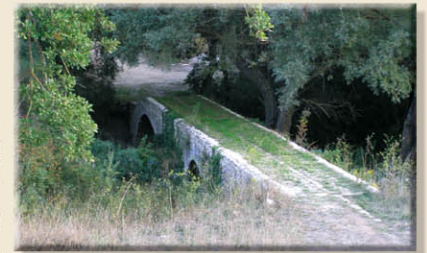
A fianco: Utilizzo delle rocce come materiale da costruzione: ponte romano a schiena d'asino in località C/da Maimone sul Fiume Imera Meridionale. Use of rocks as material for the building. Roman humpbacked bridge in the locality of C/da Maimone on the river Imera Meridionale
