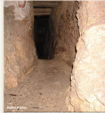
Bottino di presa
